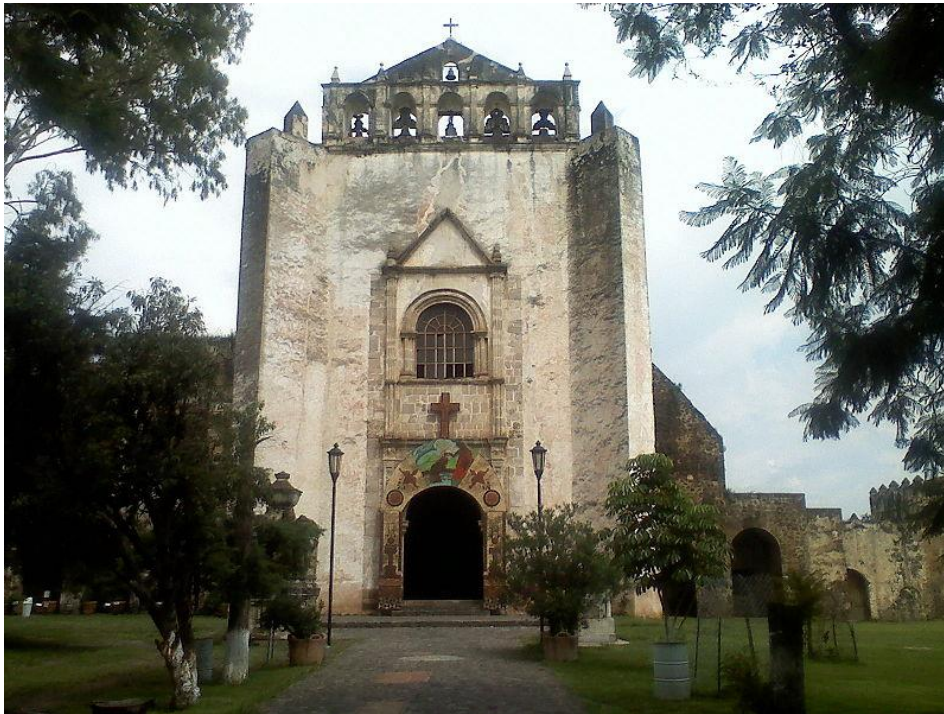
Figura 2. Fachada del exconvento de Tlayacapan, Morelos
