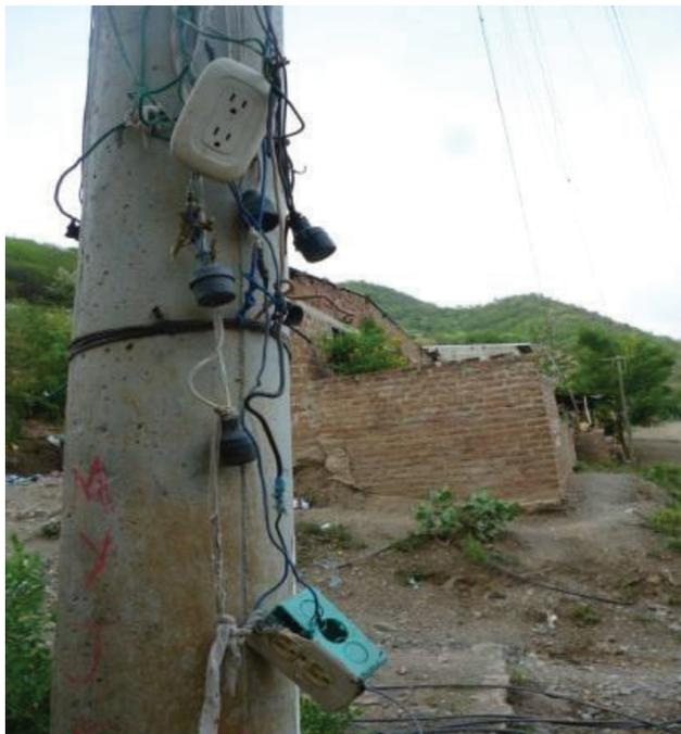
**Figura 3.** Poste de tendido eléctrico y tomacorrientes de donde se toma la electricidad para las motobombas. (Fuente: Raiza Llinás, 2013)
